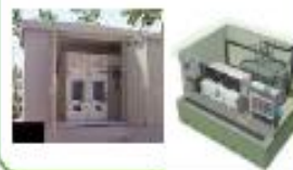
二次變電站用的 中低壓配電盤
